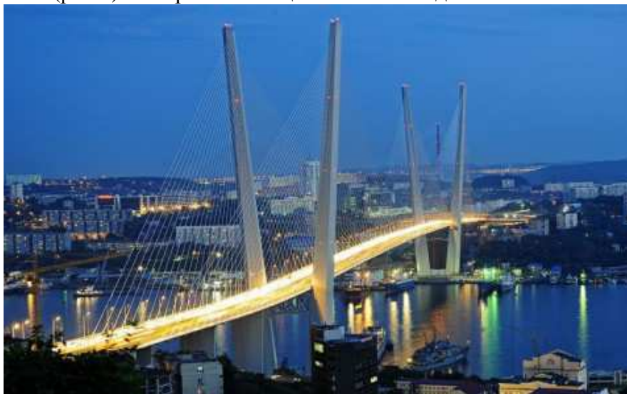
Рис. 3. Мост через бухту Золотой Рог, генеральный проектировщик ЗАО «Институт Гипростроймост — Санкт-Петербург». [Электронный ресурс] Режим доступа: http://vladtop.ru/uploads/posts/2013
