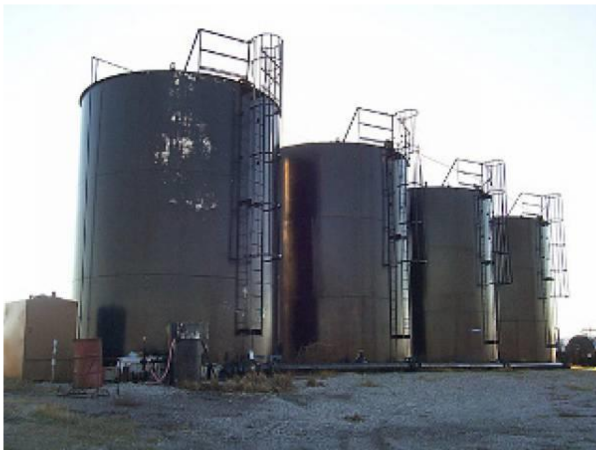
Рис. 2. Резервуар для хранения нефтешлама
